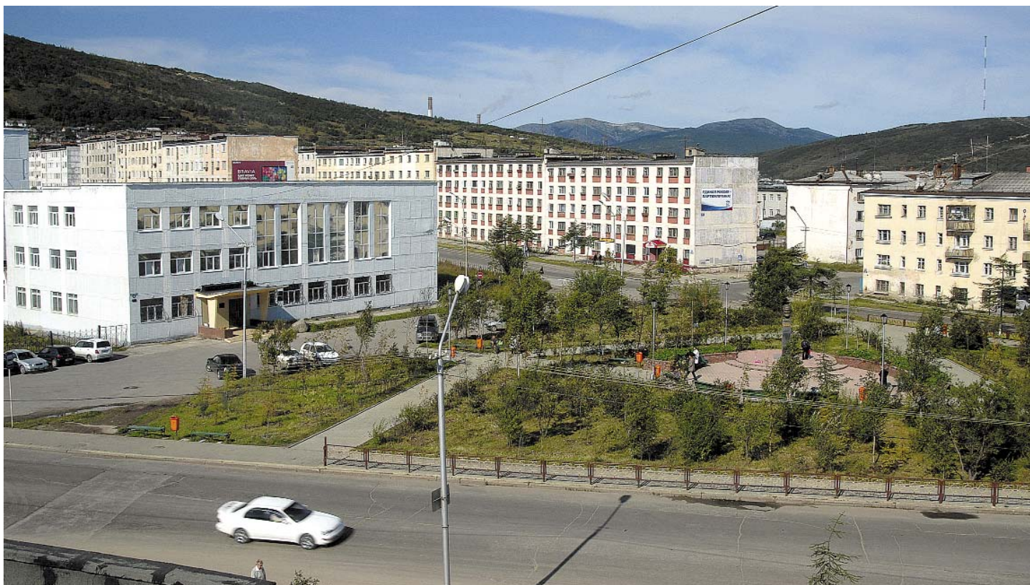
Новое здание СВКНИИ по улице Портовой, 16
